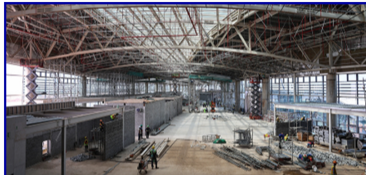
Hình 2: Công tác lắp đặt hệ thống thiết bị và hoàn thiện bên trong nhà ga.
